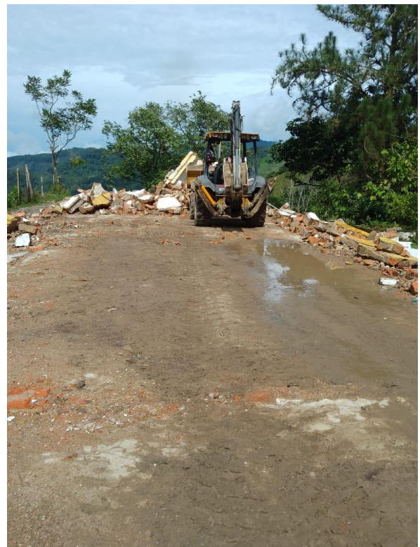
Ilustración 6: Demolición de muros y estructura de concreto reforzado. (Fuente propia)
