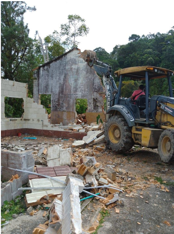
Ilustración 6: Demolición de muros y estructura de concreto reforzado. (Fuente propia)
