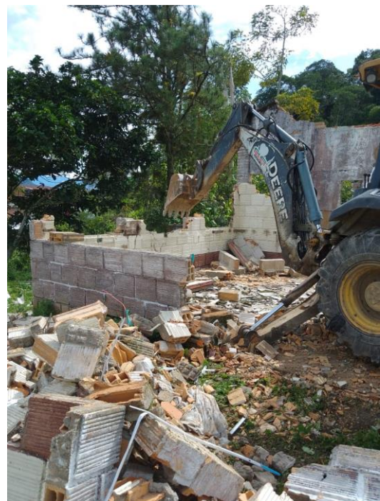
Ilustración 5: Demolición de muros y estructuras de concreto reforzado. (Fuente propia)
