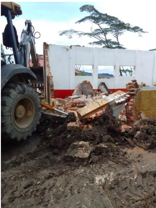
Ilustración 5: Demolición de muros y estructuras de concreto reforzado. (Fuente propia)
